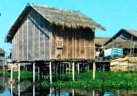
*Bambuss ir elastīgāks par koku un betonu, tāpēc ir labs būvmateriāls zemestrīcu skartos reģionos.*
