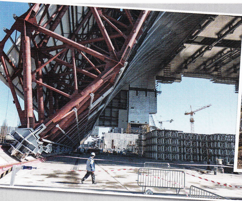
Sliežu sistēma ļaus nogādāt vietā 36 000 tonnu smago sarkofāgu.
